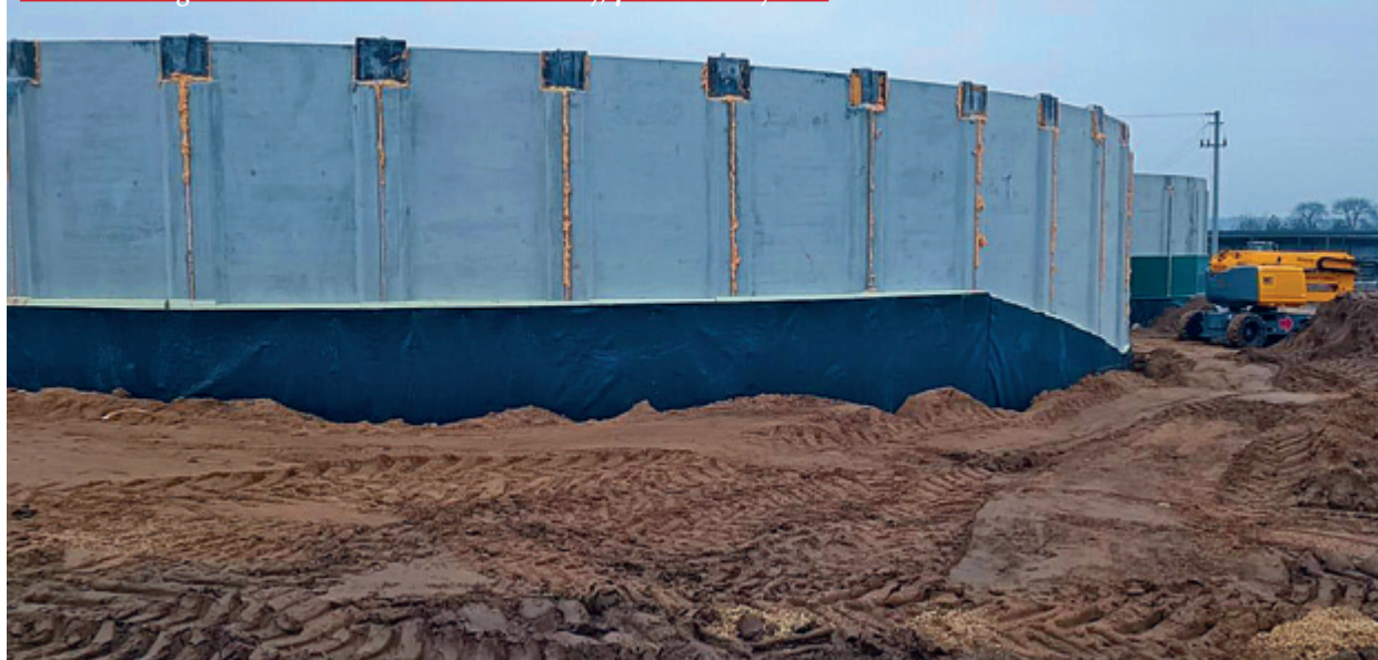
Fot. Mikrobiogazownia rolnicza w trakcie budowy, powiat łomżyński.
